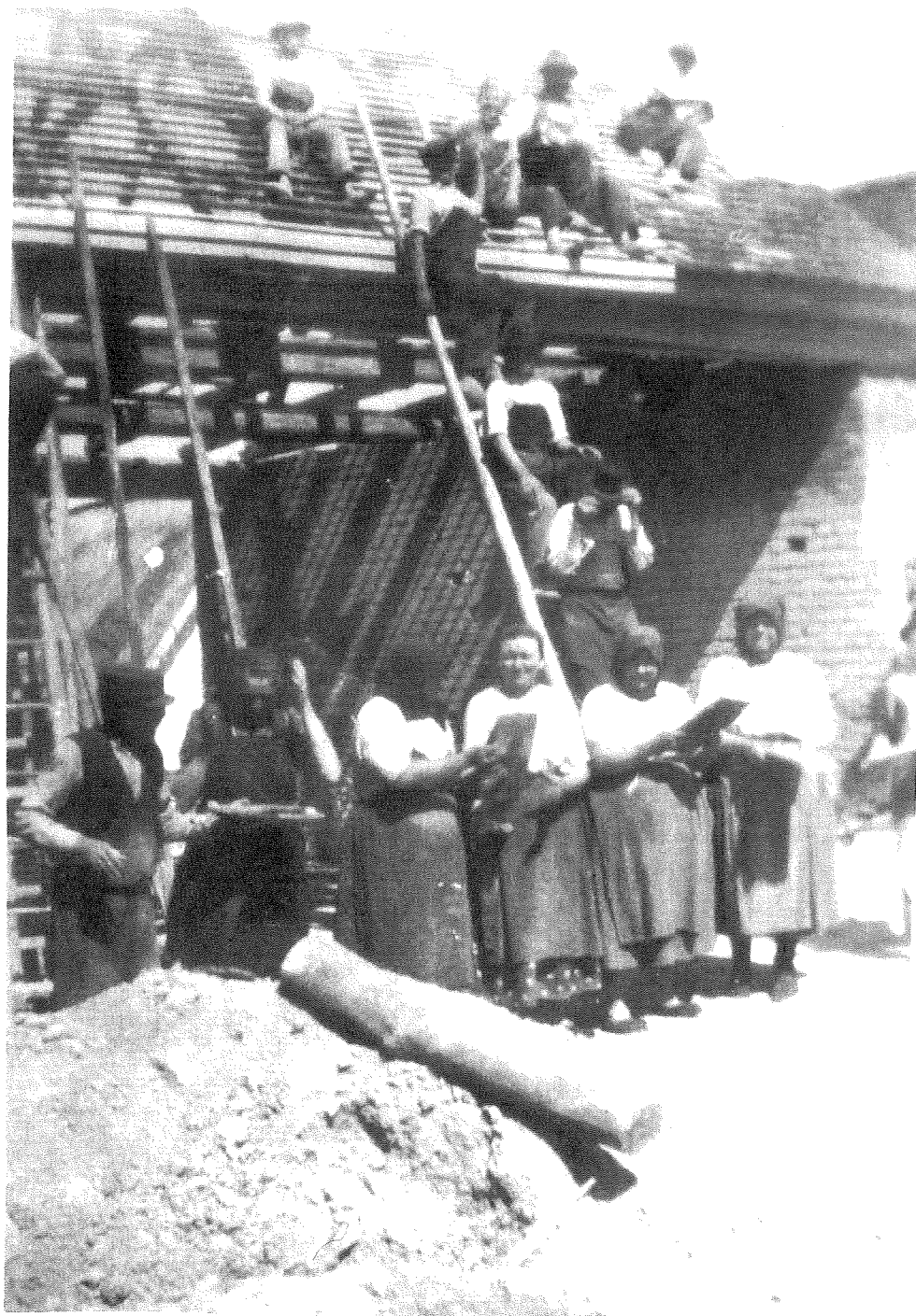
Ein Haus im Dorf wird neu gedeckt.
